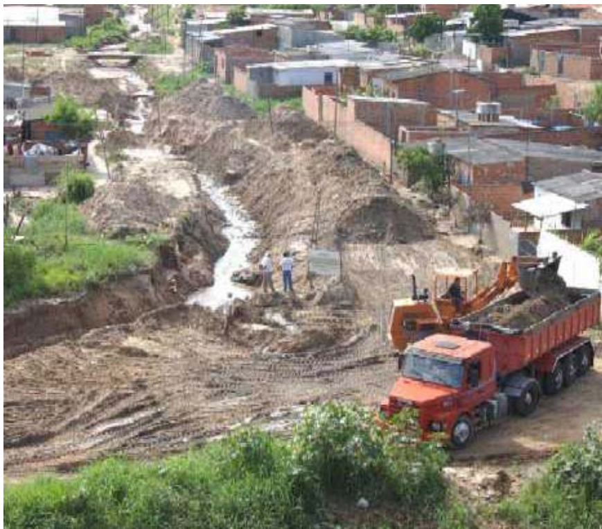
Máquinas tiveram de voltar ao Jardim Florence I devido às chuvas de Natal
